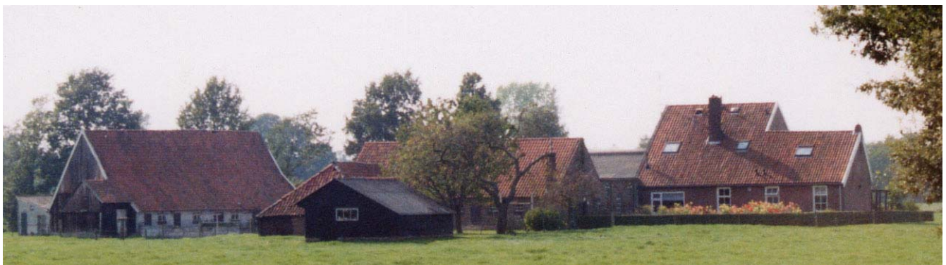
Bij een brand op de avond van 29 augustus 1986 ging het achterhuis grotendeels verloren, inclusief het monumentale gebintwerk. Slechts het muurwerk (sluitsteen deeldeur, 1822) bleef overeind. (Foto: auteur)
